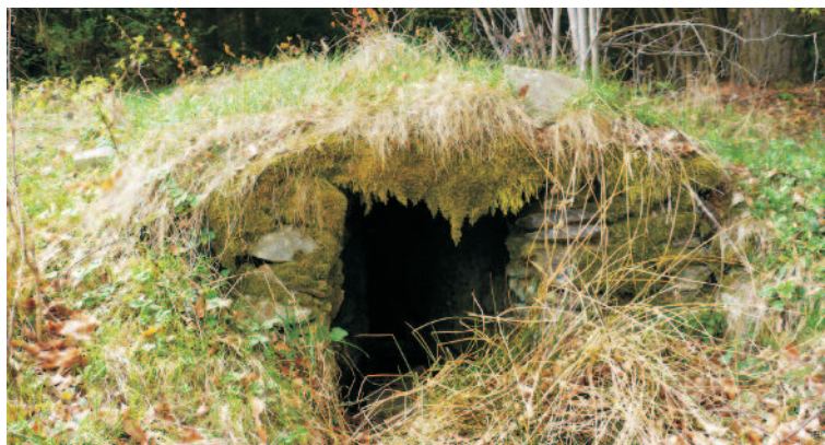
Abb. 14: Eingangsöffnung zu einer 50 m langen aus Trockenmauerwerk errichteten unterirdischen Anlage am Rabenwaldkogel. • Fig. 14: Entrance opening to a 50 m long underground passage made of dry stonework on the Rabenwaldkogel. Foto: Heinrich Kusch
