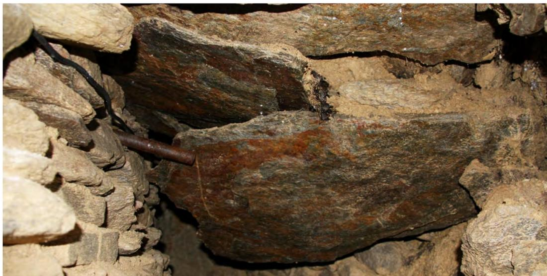
Abb. 5 Dieses Bild zeigt die zerschlagene Deckplatte, die noch auf der äußeren Kante auf dem Stahlrohr aufliegt und einen Teil des in den Gang hineingerutschten Wandteiles. Gut erkennbar sind die Schlagmarken eines Hammers auf der Stirnseite der Platte und die Spur wo die Steinüberlage auf dem Stahlrohr entlang rutschte. Foto: Heinrich Kusch
