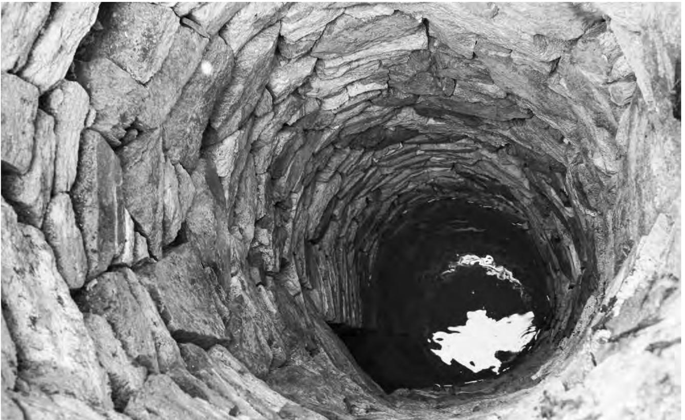
Abb. 4: Brunnenschacht mit Zustieg zu einem gemauerten Gang im Wasserniveau, Anger/Weiz. • Pit with a entrance to a stone passage near the waterlevel, Anger/Weiz. Foto: Heinrich Kusch
