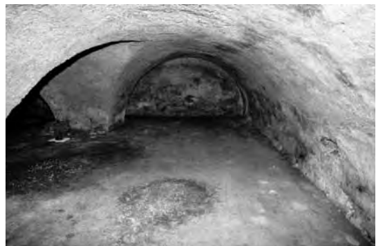
Abb. 45: Ansicht des rechten Abschnittes des Grufraumes 2. Sehr schön ist der nachträglich verjüngte, vorgezogene Deckenteil an der rechten Seite erkennbar. Die rückwärtige Stirnwand ist nach West ausgerichtet.
