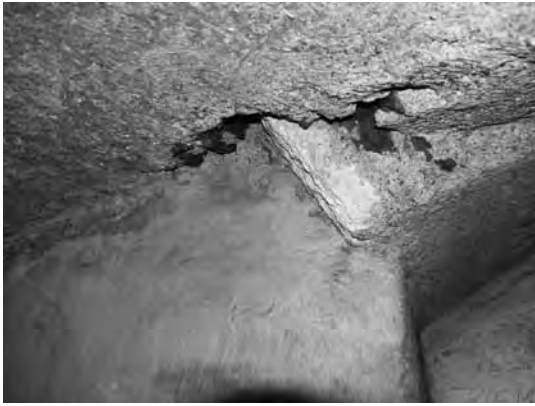
Abb. 44: Sekundär errichtete Wand- und Deckenteile im vorderen Abschnitt des Raumes 2 in der Gruft.
