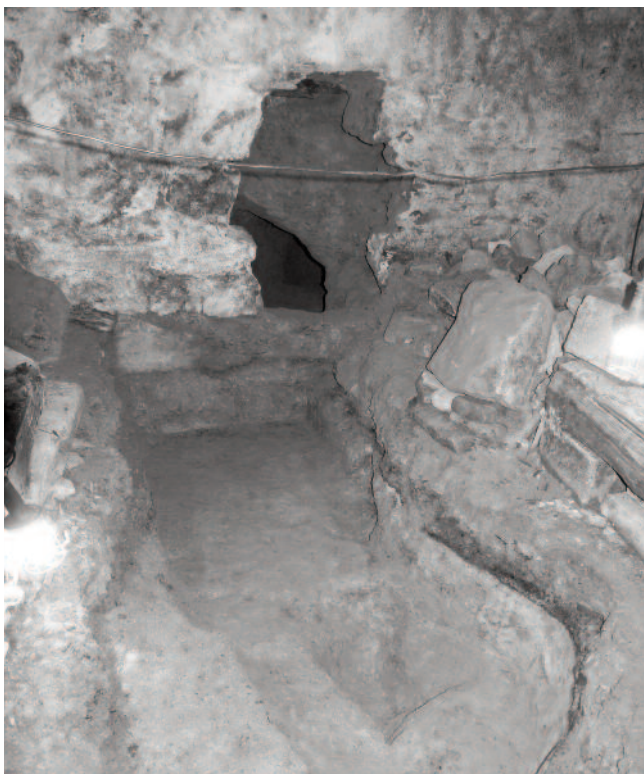
Abb. 4: Ansicht des freigelegten Gangverlaufes im Kellerraum des Gehöfts Schrotter. Der einstige Felsgang selbst wurde beim Hausbau im 14. Jahrhundert bis auf eine Resthöhe von 0,2 bis 0,3 m komplett aus dem Fels herausgeschnitten und mit Abraum verfüllt. • View of the exposed passage in the cellar of the Schrotter farmhouse. When building the house in the 14th century the former rock passage even was completely cut out from the rock up to a residual height of 0.2 to 0.3 m and backfilled with overburden. Foto: Heinrich Kusch
