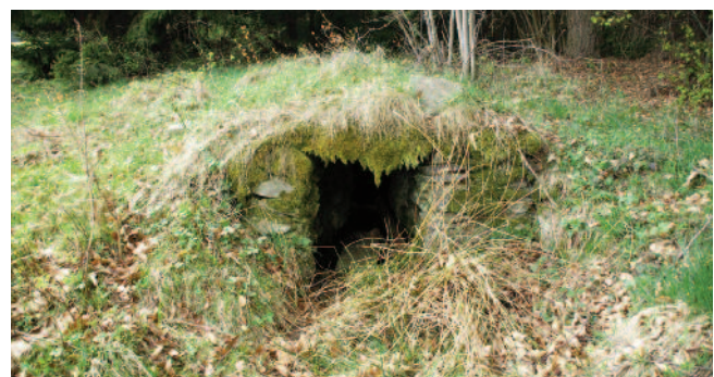
Abb. 9: Eingangsöffnung eines rund 50 m langen gemauerten Steinganges im Pöllauer Tal • Entrance of a 50 meter long stone bricked passage in the Pöllau valley; Foto: Heinrich Kusch
