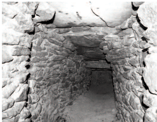
Abb. 1: Beispiel eines mit Trockenmauern errichteten Steinganges, der zum Teil mit bis zu einer Tonne schweren Deckplatten abgedeckt ist und in 4 m Tiefe unter der Oberfläche verläuft. • Example of a passage built with dry stone walls, which is partly covered with up to a ton of heavy cover plates and extends to a depth of 4 m below the surface. Foto: Heinrich Kusch
